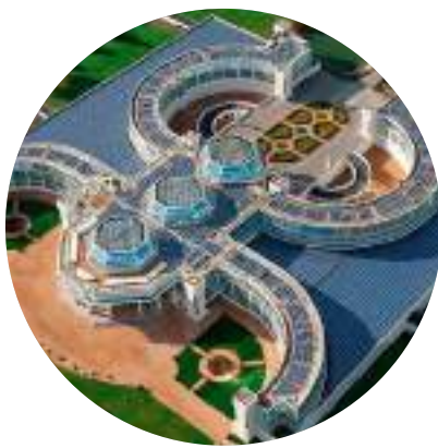
Siège social Challenger, Bouygues Construction, Paris
